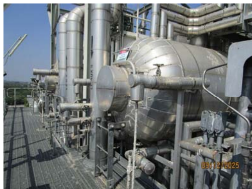
รูปที่ 52 ผนวมน้ำเปลือกหม้อไอน้ำและท่อที่ร้อน
