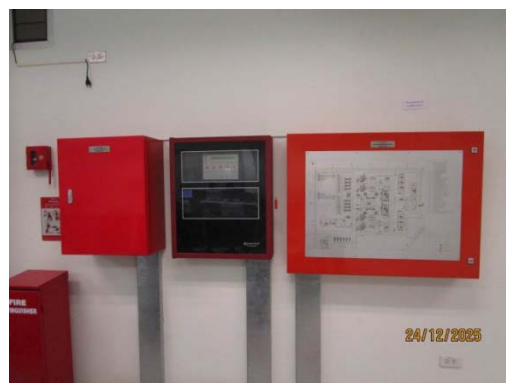
รูปที่ 31 ระบบสัญญาณเตือนภัย (Fire alarm)
